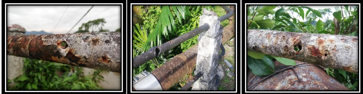
Rajah 7, 8 dan 9 (Dari kiri ke kanan): Gambar menunjukkan kesan tembakan yang terdapat pada Jambatan Slim River.
