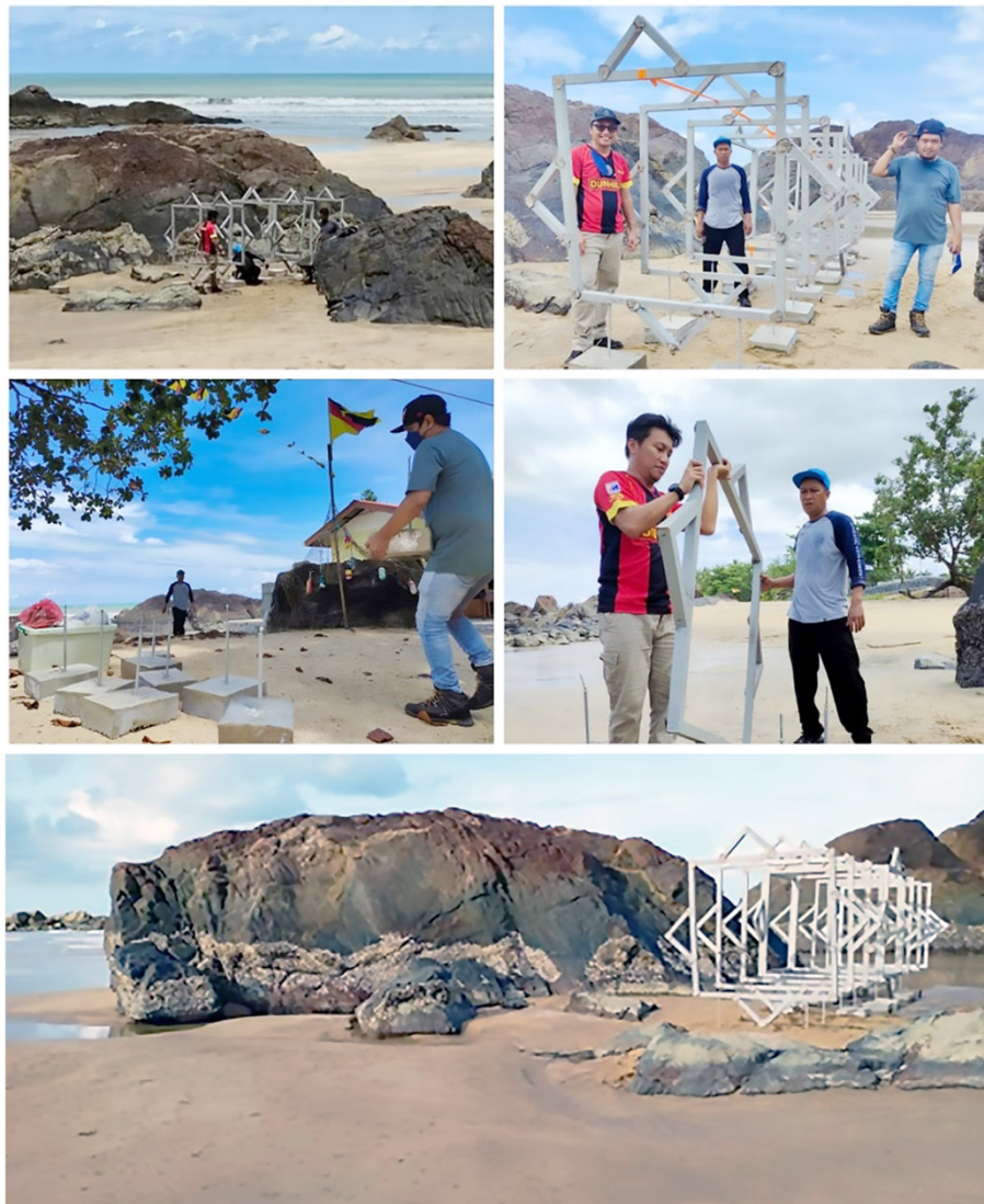
Foto 5 Proses pemasangan karya Maqassid Di Dasar Mu di lokasi yang dipilih. Sumber: Foto sumbangan seniman, 2021.
